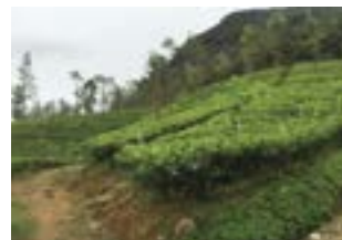
カバークロップ (右側法面)
