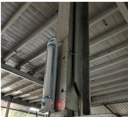
非常用照明設備の設置
