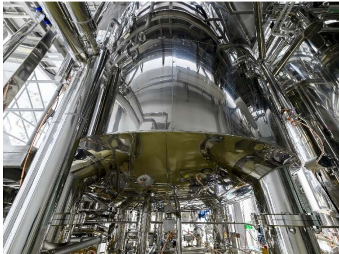
協和キリン高崎工場 (群馬県) バイオ医薬品製造タンク
