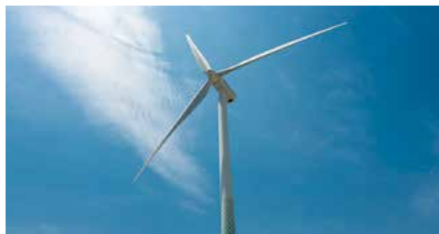
横浜市風力発電所（ハマウィング）
