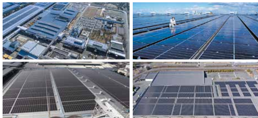
工場に導入された大規模太陽光発電設備
