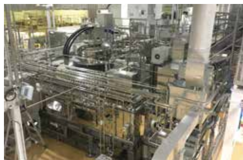
湘南工場で導入したエアーリンス設備
