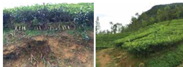
左：土壌流出防止対策前、右：対策後
