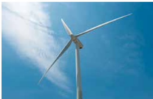
横浜市風力発電所 (ハマウイング)
