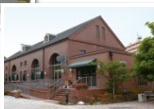
SPRING VALLEY ▶ BREWERY YOKOHAMA (仮称) 〈麒麟ビール横浜工場内〉
