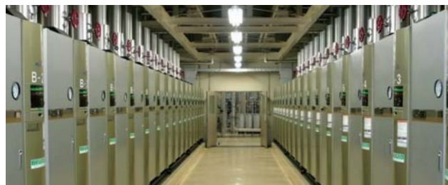
ガスボイラー
