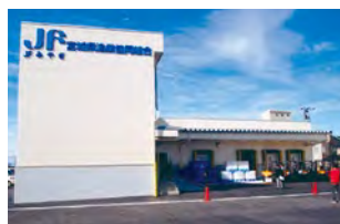
復旧した宮城県漁業協同組合生かき保管冷蔵施設
