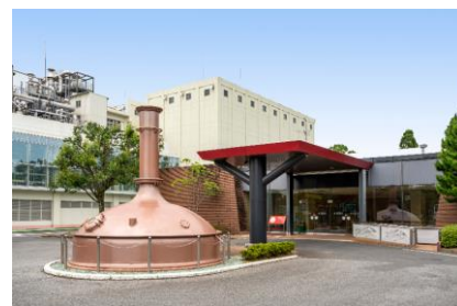
<キリンビール取手工場外観>
