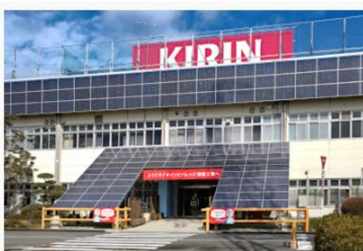
図-2 キリンビバレッジ湘南工場外観
